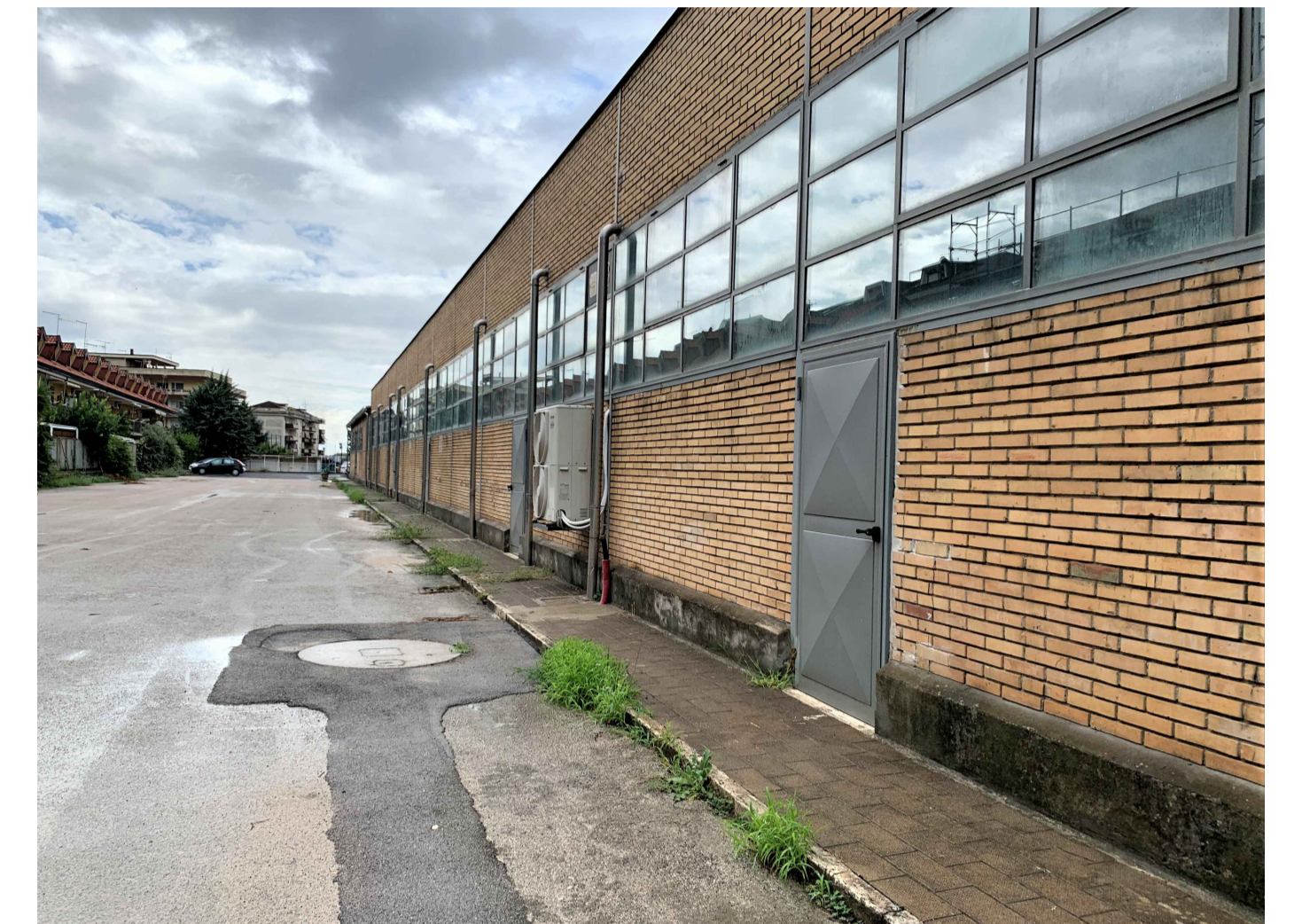
Foto esterno Prospetto Est
